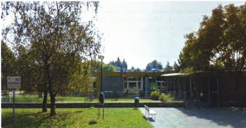
Vista ingresso frontale
