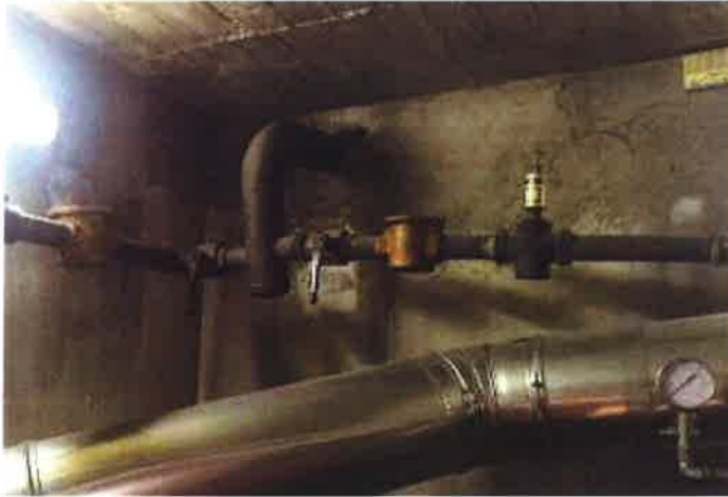
Dettaglio canna fumaria e ingresso tubazione gas dotato di VIC
