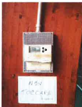
Dettaglio regolatore della temperatura intera
