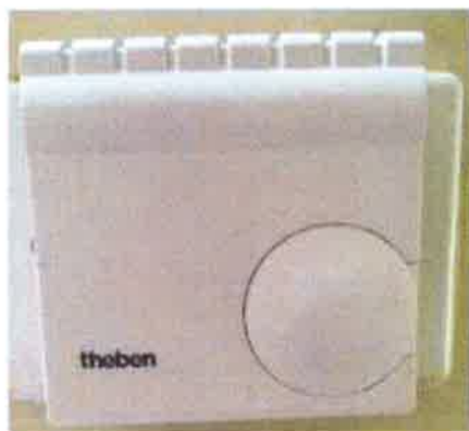
Regolatore di temperatura ambiente alla nuova
