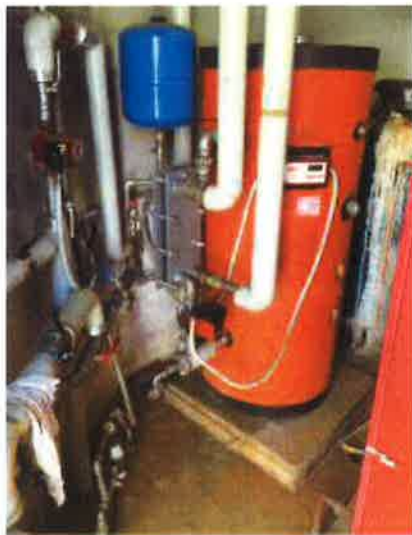
Boiler Produzione di ACS
