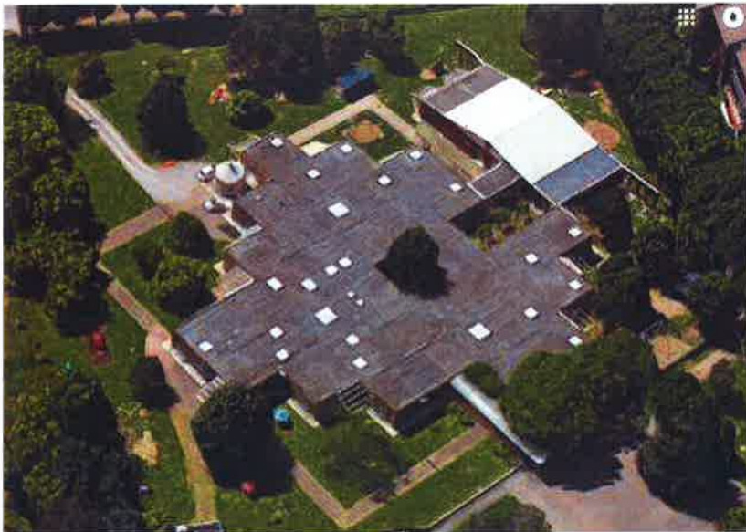
Vista dall'alto dell'edificio
