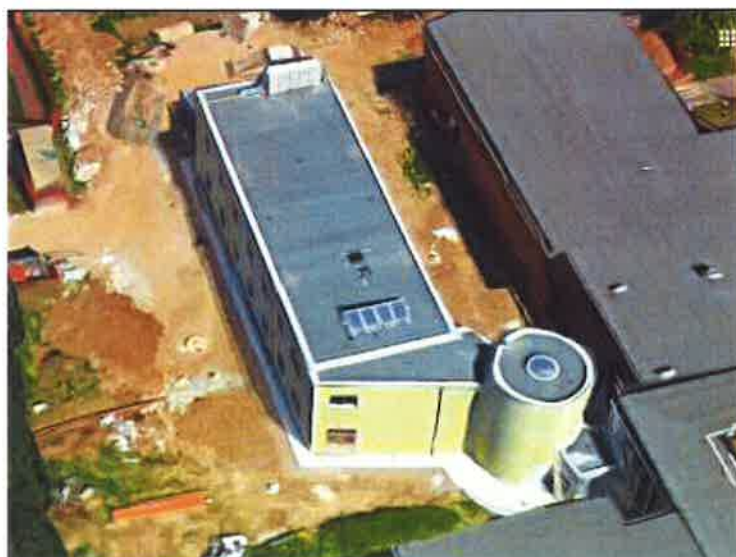
Vista di dettaglio della nuova ala
