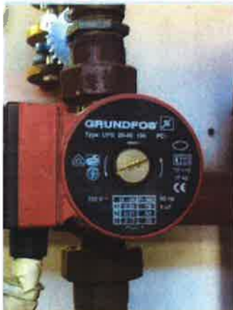
Dettaglio circolatore anticondensa P1
