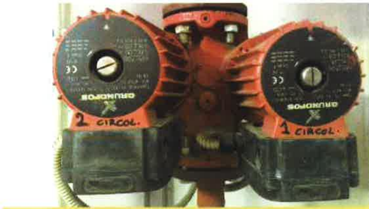
Dettaglio circolatore anticondensa P1
