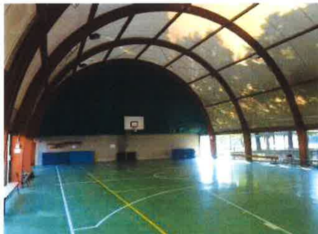
Vista interna tensostruttura
