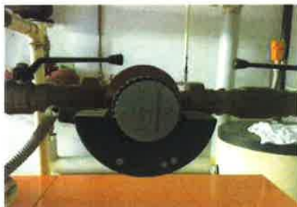
Pompa P1 - Anticondensa
