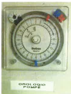
Dettaglio orologio per la termoregolazione
