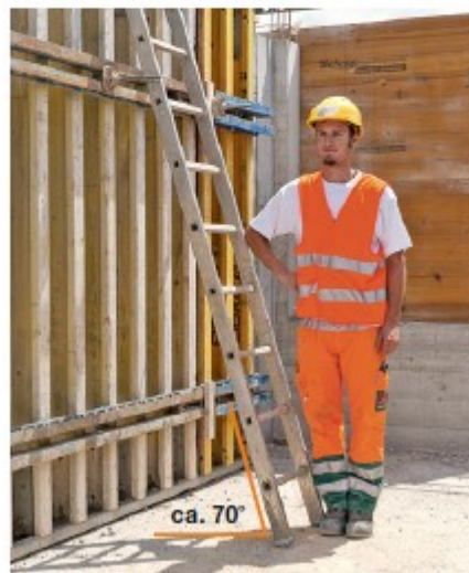
6 Verifica dell'angolo di inclinazione (circa 70°) con la prova del gomito
